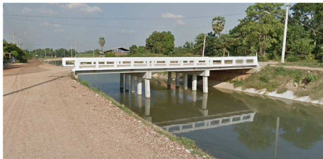
รูปที่ 16 แสดงรูปสะพานรถยนต์ข้ามคลอง
