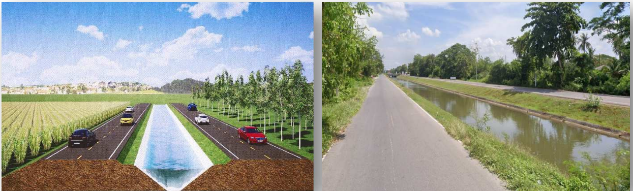
รูปที่ 13 แสดงภาพจำลองคลองส่งน้ำสายหลัก MC และตัวอย่างคลองส่งน้ำลาดคอนกรีต
